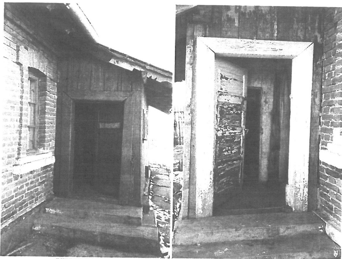
VEDERE EXTERIOR INTRARE ESTICA ȘI VESTICA
