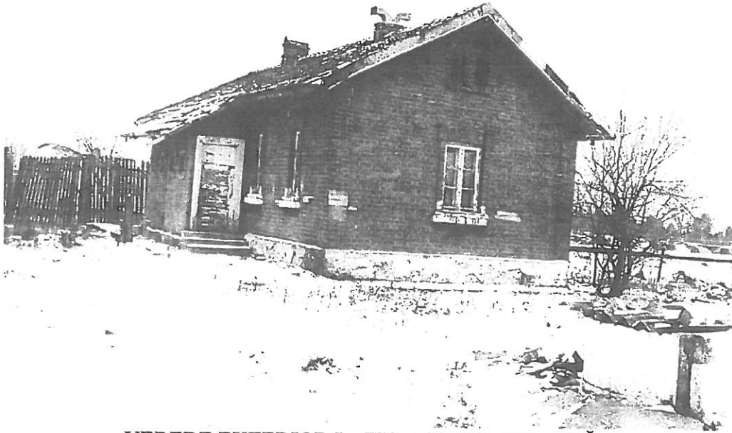
VEDERE EXTERIOR LATURA NORD- VESTICĂ
